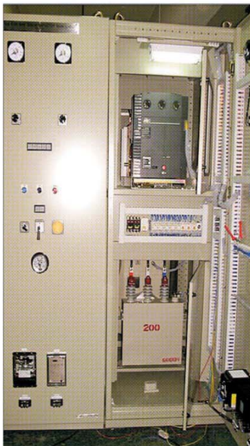
《3.3kV 3P 50Hz 300kvar》
