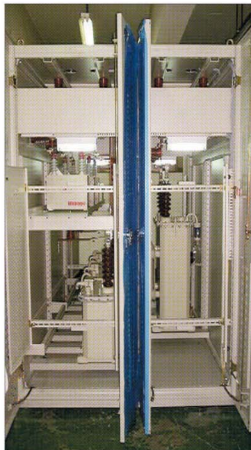
《10kV 3P 50Hz 700kvar》
